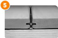
Faites glisser les clips (vis et goussets) le long de la rainure, en en plaçant un sur chaque solive, de part et d'autre de la planche.
