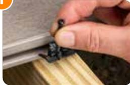
Incline el clip StealthLock de modo que las puntas inferiores entren primero en la ranura. Enderece el clip para que calce en la ranura. Los clips quedarán colocados hasta que esté todo listo para sujetarlos.
