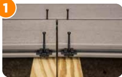
**1** Coloque 4 clips centrados en la viga en ambos lados de las tablas.
