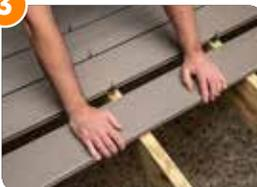
Deslice la siguiente tabla en los clips y repita el paso hasta que tenga varias filas de tablas y clips.
