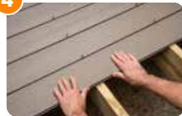
Coloque las tablas con firmeza o ajústelas con CAMO LEVER® (se vende por separado).
