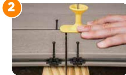
**2** Coloque la siguiente tabla en los clips y, luego, ajuste los tornillos.
