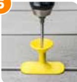
Comenzando por la tabla exterior, coloque la guía NEVER-MISS® (incluida en los cubos de 450 y 900 piezas) sobre la parte superior del tornillo. Conecte la broca con la parte superior y atornille hasta que el clip esté ajustado. **No los atornille en exceso.** Repita el paso hasta que todas las tablas interiores estén sujetas.
