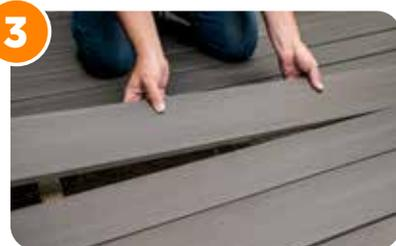
**3** Retire los clips que hayan quedado en las vigas y coloque la nueva tabla para terraza sin ningún clip.
