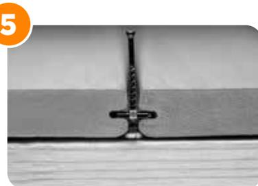
**5** Deslice los clips (tornillos y herrajes) por la ranura y coloque uno sobre cada viga en ambos lados de la tabla.
